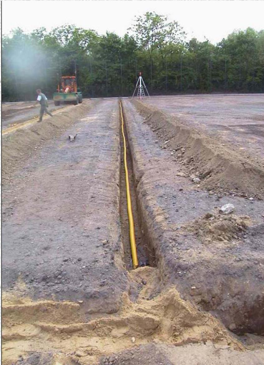
Einbau der Drainage unter Beachtung der Vorgaben in **DIN 18035-3 „Entwässerung“**
